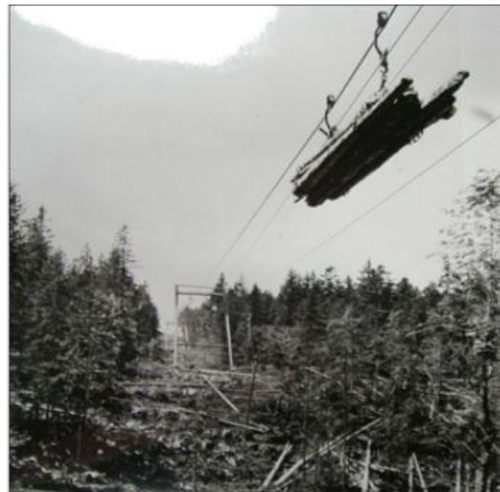
Transports de bois pour les papeteries, sur tricâble, vers 1930.
