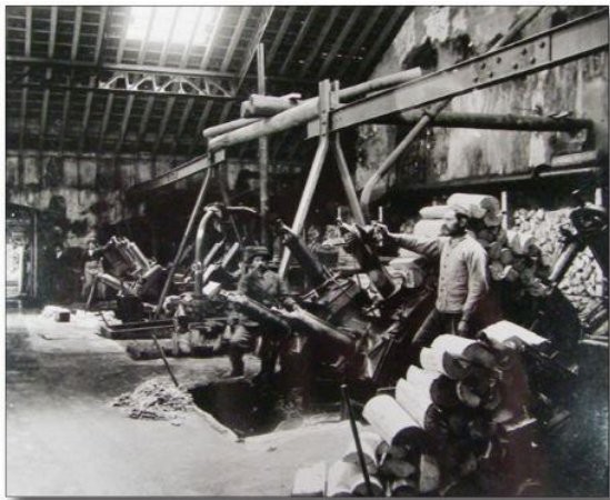
La salle des défibreurs aux Papeteries de France. Lancey, Isère.
