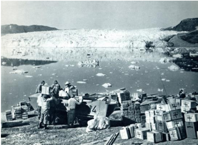
Le déchargement du matériel à Port Victor en 1948
