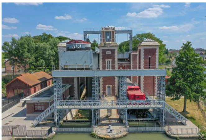
Illustration 1 : L'ascenseur à bateaux des Fontinettes. On voit les deux caissons, celui de gauche est au niveau amont du canal, alors que celui de droite est au niveau aval.
