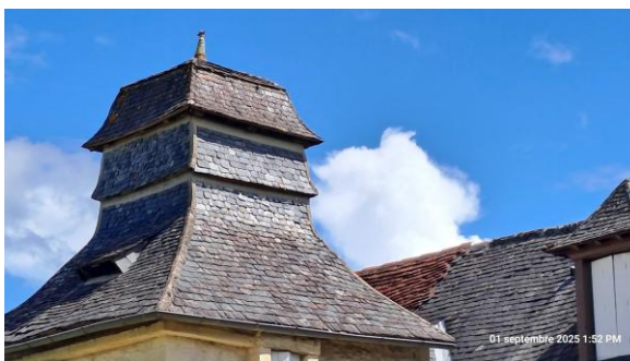
Toiture à Saint Robert
